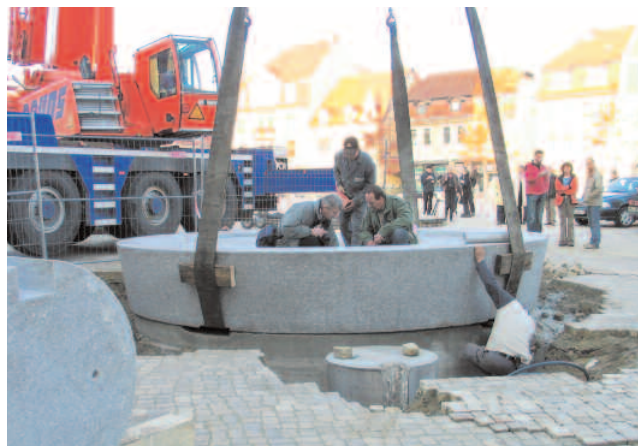
Montage des 37 Tonnen schweren Brunnens
